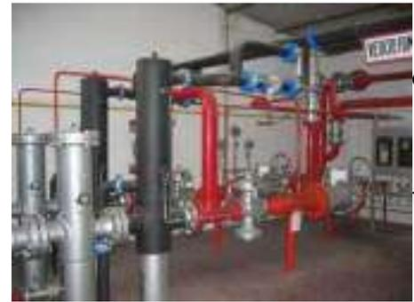
Sulla tubazione del gas prima di ogni apparecchio è posizionato un rubinetto, in maniera tale da consentirne l'intercettazione in caso di pericolo o comunque per necessità di manutenzione.
